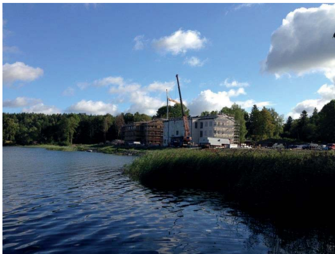
Figur 2. Flerbostadshus under uppförande i Sundsvik.
